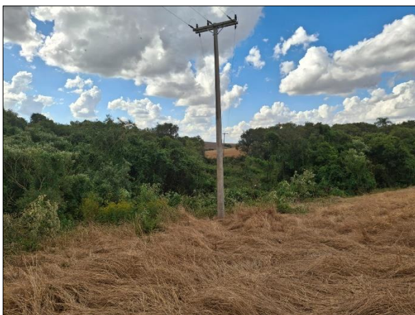
Figura 17. Ponto n. 1430, após execução da roçada na faixa de segurança.
