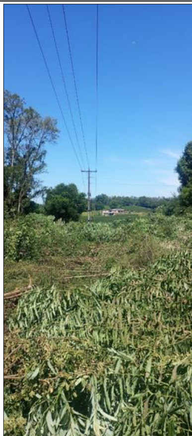
Figura 23. Ponto n. 0976, D. Chorão - Ijuí, após a execução da roçada, sob rede trifásica.
