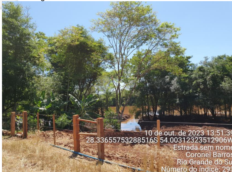
Figura 10 - Acesso ao reservatório e cercamento.
