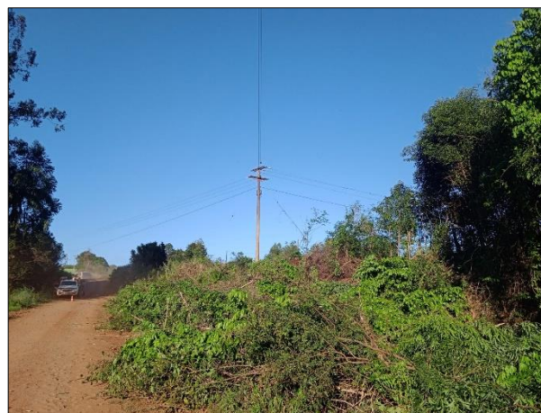
Figura 6. Ponto 0512 após execução da roçada, com 688 m² de roçada em 2024. .
