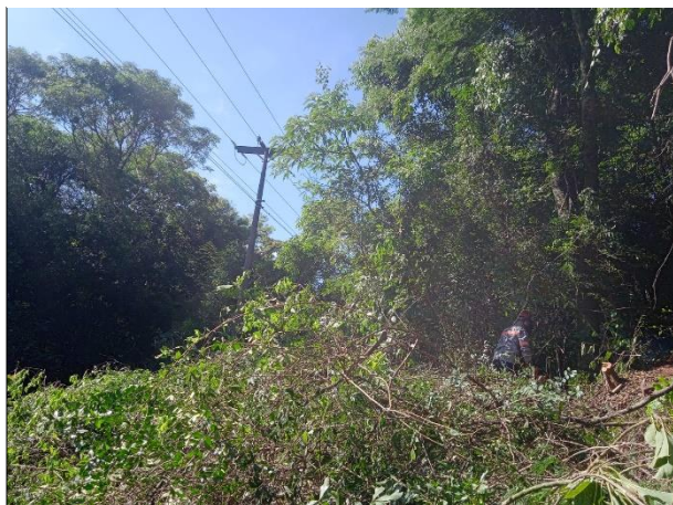
Figura 11. Ponto de Roçada 0750 (Ijuí, margens da RS-155, próximo a subestação RGE), durante execução de roçada de 3.440 m².
