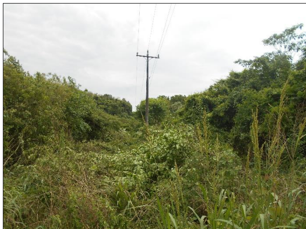
Figura 9. Ponto de Roçada 0743 (Linha 15 – Ajuricaba-RS), antes da roçada.
